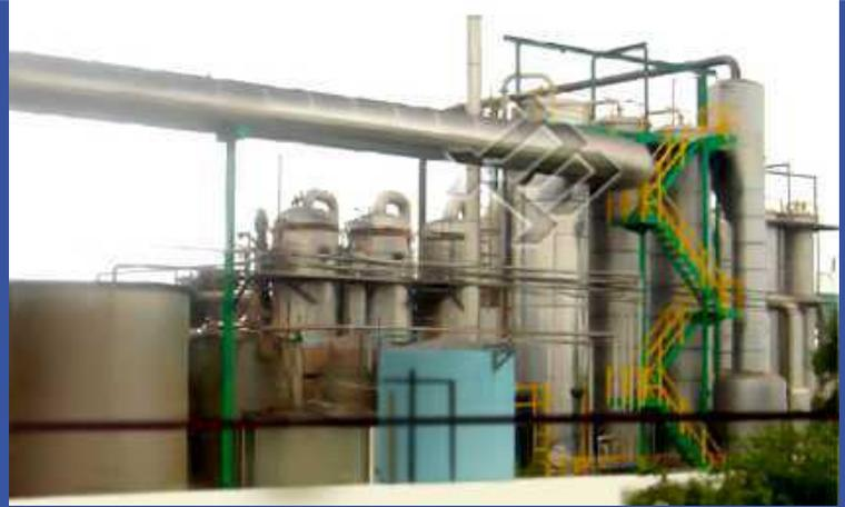
DISEÑO, FABRICACIÓN Y MONTAJE DE DUCTOS. EN LA VISTA: ALIMENTACIÓN DE VAHOS A PLANTA EVAPORADORA. DIÁMETRO 1200 mm EN I-304 CON ANILLOS DE REFUERZO PARA INSTALACIÓN DE AISLAMIENTO.
