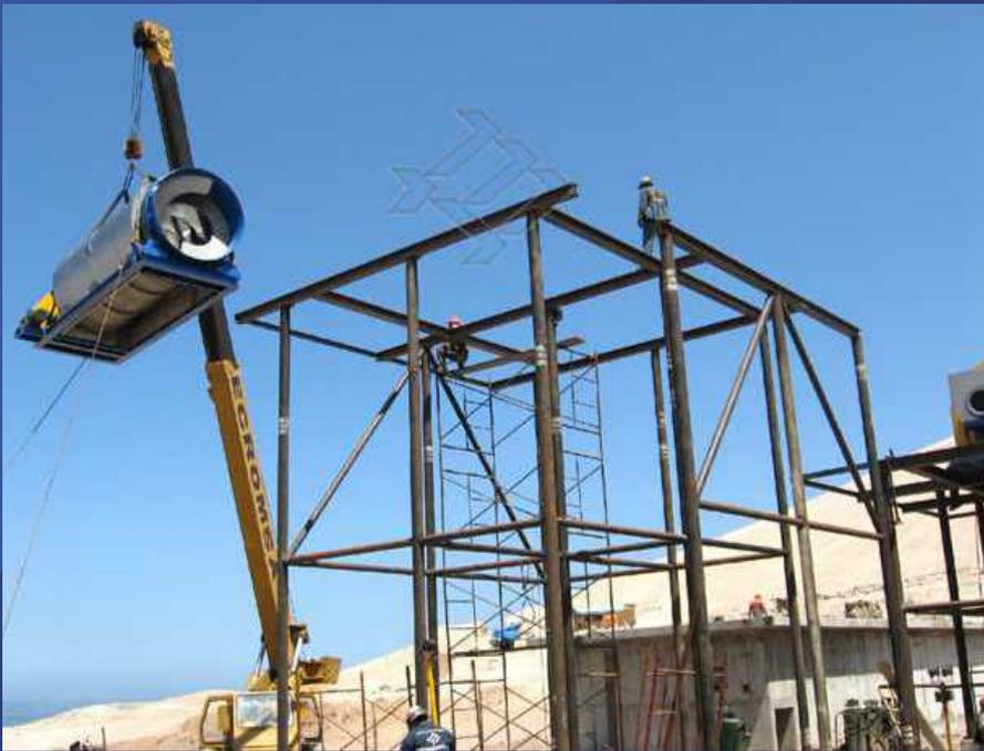
DETALLE DE PROCESO DE MONTAJE EN LA SECCIÓN DE DESCARGA DE PESCADO Y RECUPERACIÓN DE SÓLIDOS DE AGUA DE BOMBEO.
