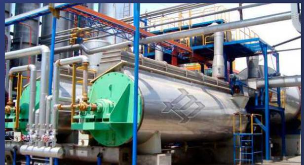
RETIRO DE SECADORES FAQ PARA TRANSFORMACIÓN EN SECADO CON VAPOR. INCLUYE MONTAJE Y REPARACIÓN DE 02 SECADORES TIPO ROTADISCOS, ALINEAMIENTO DE TRANSMISIÓN, REDES DE VAPOR Y CONDENSADO, DUCTO DE VAHOS. FABRICACIÓN Y MONTAJE DE TRANSPORTADORES HELICOIDALES Y MOLINO HÚMEDO EN I-304.
