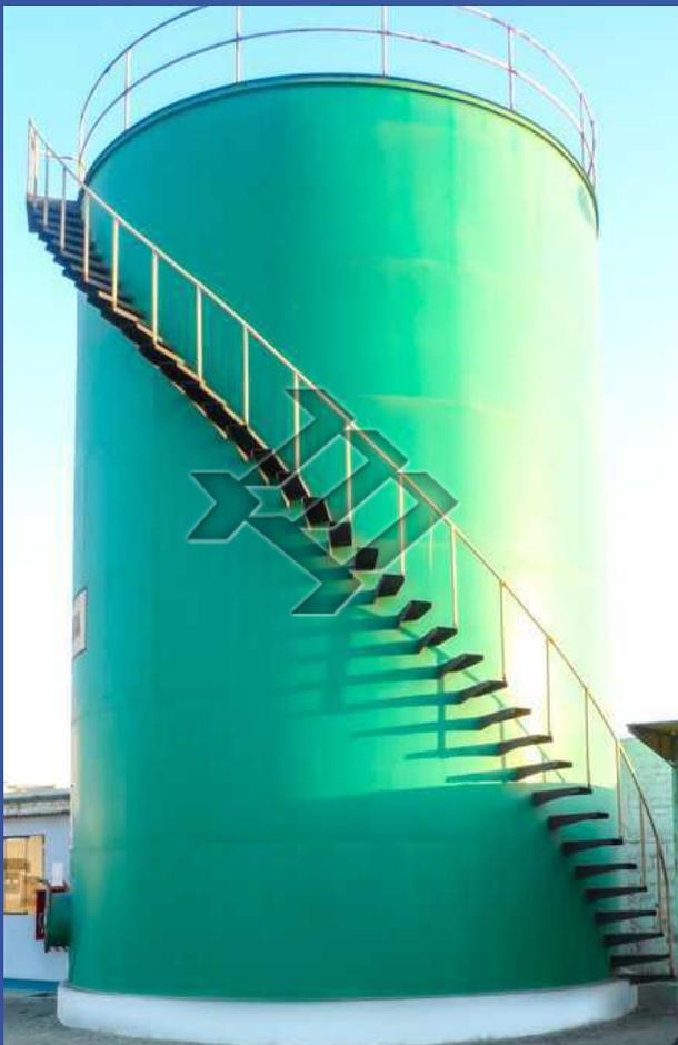
DISEÑO Y FABRICACIÓN SEGÚN NORMA API 650, EN A-36 DE TANQUE PARA AGUA DURA DE 330 m3 DE CAPACIDAD. 22 mils EN CAPAS DE PINTURA.
