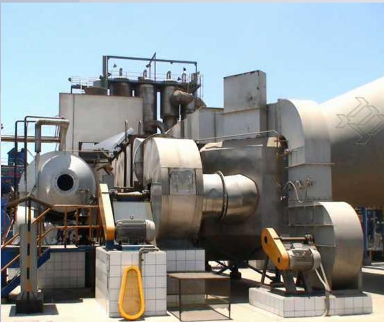
MANTENIMIENTO DE GENERADOR DE AIRE CALIENTE PARA SECADO DE HARINA. INCLUYE REFRACTARIO, TABLERO DE CONTROL ELÉCTRICO Y REGULACIÓN CON PUESTA EN MARCHA.
